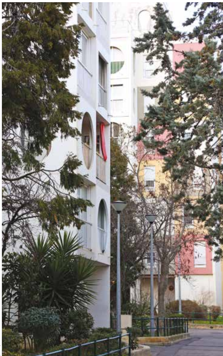
Le quartier de Paradis Saint-Roch a été construit en 1973 et comporte près de 500 logements.
