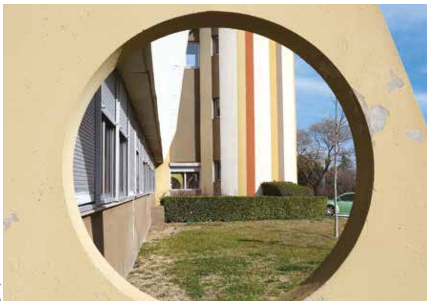
La Maison des syndicats a été construite dans les années 80.
