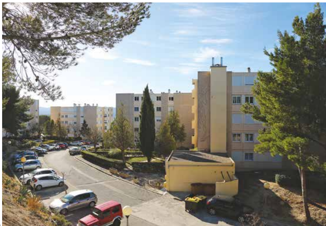
La Coudoulière est une résidence de 171 logements à Croix-Sainte, datant des années 70 et qui a besoin d'une meilleure isolation thermique.
