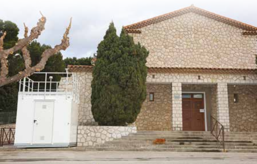
La station de mesure de la qualité de l'air est désormais beaucoup plus visible.
