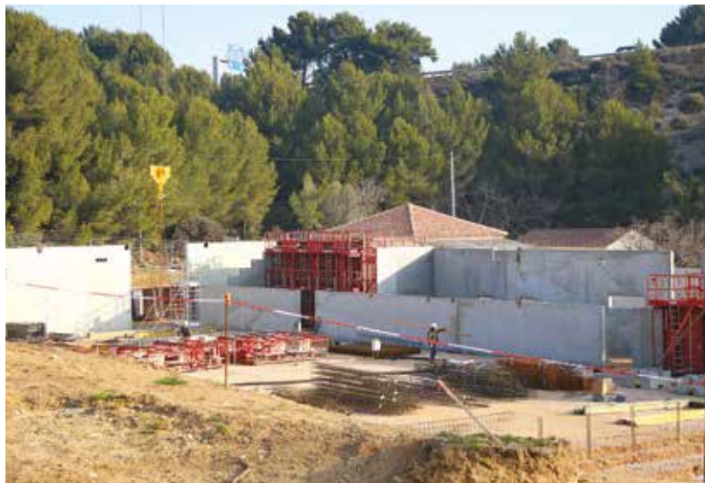
La salle omnisports en construction, au bd Urdy Milou. Elle devrait ouvrir en décembre 2017.
