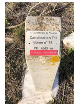
Les canalisations sont identifiées par une étiquette avec l'exploitant et son numéro, éventuellement le type de matière transportée, la profondeur des canalisations.
